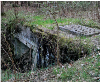
Schron B.19; po lewej stanowisko ogniowe, po prawej stanowisko obserwatora przykryte płytami betonowymi; fot. Jarosław Leszczeńowski
