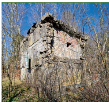
Dwukondygnacyjny schron Lz.VIII; dwór został rozebrany; fot. Jarostaw Leszczetowski
