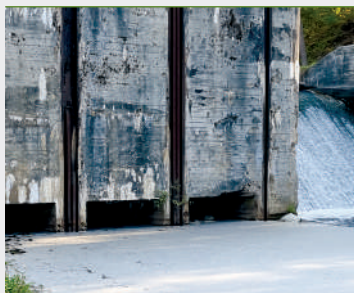
Wyloty kanałów przepustowych; fot. Jarosław Leszczetowski
