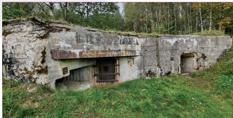
Schron bojowy i dowodzenia na południe od Sępólna Wielkiego; fot. Jarosław Leszczetowski
