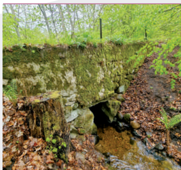
Przepust nad strugą wzmocniony betonem; fot. Jarosław Leszczękowski
