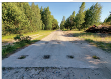
Pozostałości zapory przeciwpancernej na drodze Gwda Wielka - Spore; fot. Jarosław Leszczetowski
