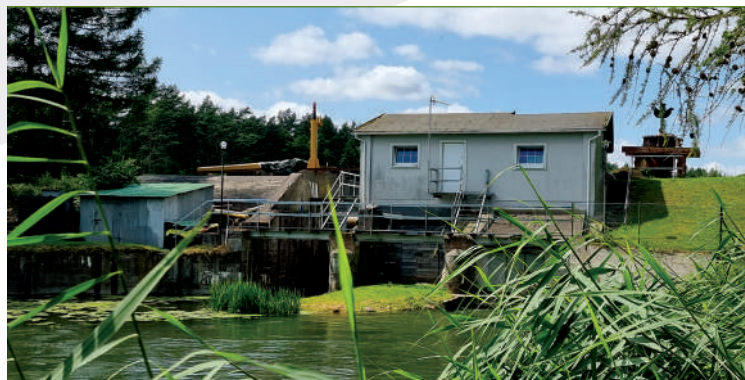
Jaz kłapowy na Piławie; po prawej budynek współczesnej elektrowni, po lewej betonowy korpus pomieszczenia technicznego jazu; fot. Jarosław Leszczetowski
