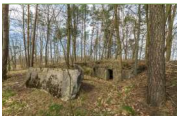
Przedpiersie i izba bojowa schronu Du.30; fot. Maciek Leszczetowski
