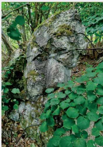
Resztki dwusektorowego schronu bojowego Du.1 w Dąbrowicy; fot. Jarosław Leszczetowski
