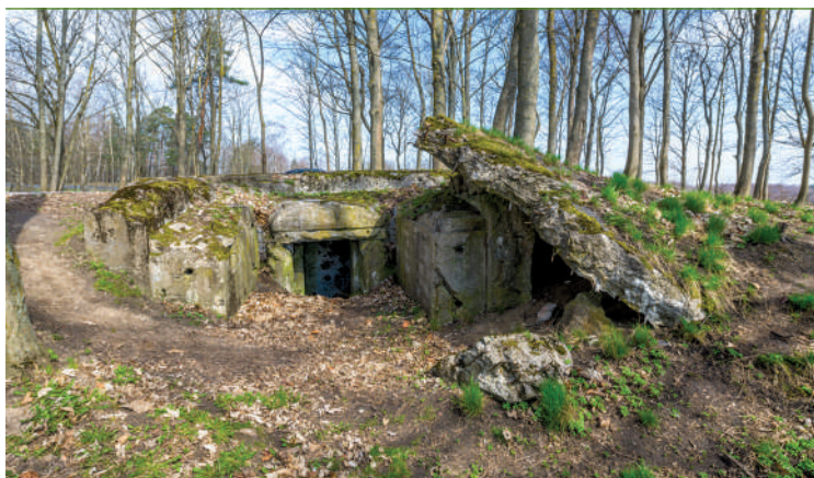
Schron Du.22; widok na izbę bojową ostoniętą niegdyś kazamatą; widać też wejście do korytarza; fot. Maciek Leszczetowski
