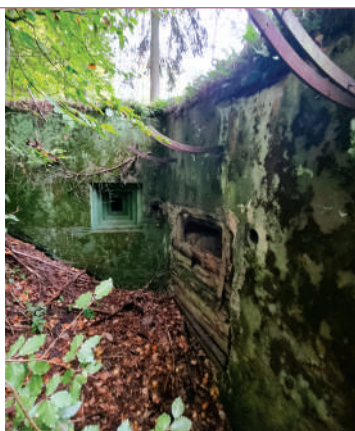
Elewacja wejściowa schronu Karz.6 ze schodkową ambrazurą strzelnicy obrony zewnętrznej;
