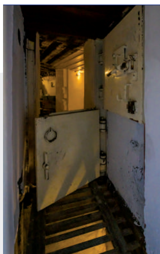
Wejście do schronu N.2 ze zrekonstruowanymi stalowymi drzwiami; wejście chronione było przez zewnętrzną strzelnicę (po prawej ambradura strzelnicy) oraz strzelnicę obrony wewnętrznej; fot. Maciek Leszczetowski
