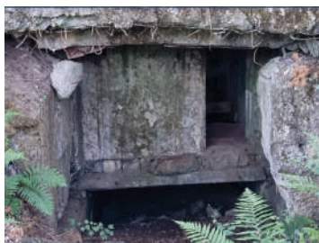
Schron E.15 widok od czoła na dwie kondygnacje; fot. Jarosław Leszczeński
