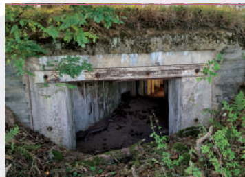
Widok na większą izbę bojową; widać sześć kotw do mocowania płyty pancernej o grub. 10 cm; schron Karz.14; fot. Jarosław Leszczetowski
