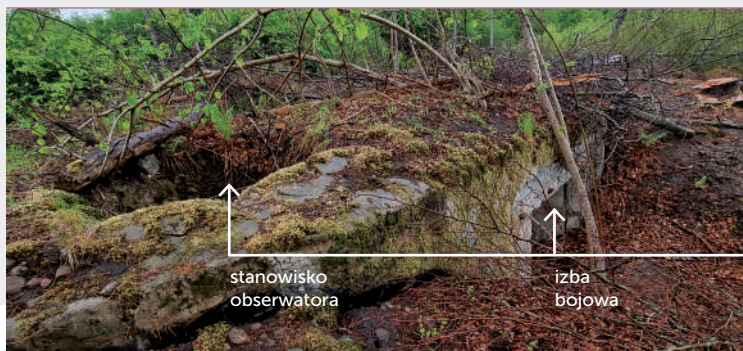
Schron Karz.21 ; po lewej pomieszczenie obserwatora artyleryjskiego; po prawej izba bojowa obsługi ckm MG08; fot. Jarosław Leszczetowski
