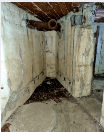
Pomieszczenie na zapas wody; dolna kondygnacja schronu Pz.W.975 ; fot. Jarosław Leszczeńowski
