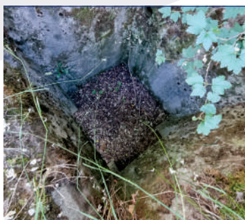
Zewnętrzne stanowisko obserwacyjne w schronie E.8; fot. Jarosław Leszczetowski
