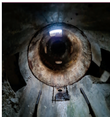
Po lewej stanowisko obserwatora w schronie B.20; po prawej obserwacyjna kopuła pancerna 9P7 w schronie B.20, na drugim planie kanał; fot. Jarosław Leszczeńowski
