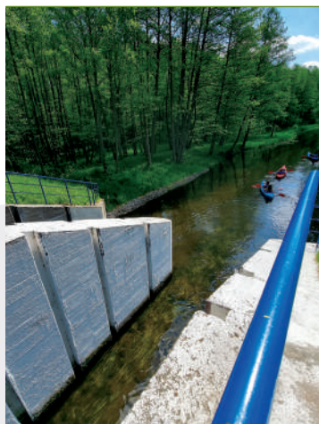
Jaz Starowicki; widoczne prowadnice, w których umieszczano belki; fot. Jarostaw Leszczetowski
