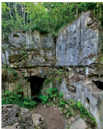
Po zerwaniu stropu, pomieszczenia dolnej i górnej kondygnacji tworzą dużą komorę; Pz.W.975 ; fot. Jarosław Leszczeńowski
