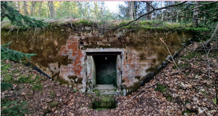
Elewacja wejściowa schronu De.18 ; fot. Jarosław Leszczetowski
