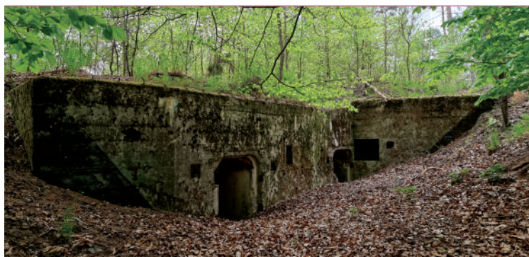
Elewacja wejściowa schronu Karz.30; widać dwa wejścia, strzelnicę obrony zewnętrznej, otwory wentylacyjne oraz niszę z wyprowadzeniem łącza telefonicznego; fot. Jarosław Leszczelewski;
