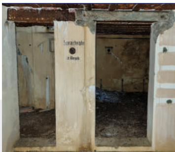
Izba pogotowia schronu K.2; od lewej: drzwi do węzła łączności, rura głosowa do komunikacji z obserwatorem, drzwi do pokoju dowódcy, w którym była również rura głosowa (widoczna w głębi pokoju); fot. Jarostaw Leszczyłowski
