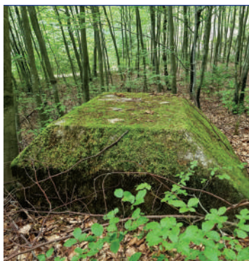
Podstawa odciągów wieży obserwacyjnej; fot. Jarosław Leszczetowski
