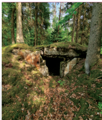
Elewacja wejściowa schronu De.32; fot. Jarostaw Leszczetowski
