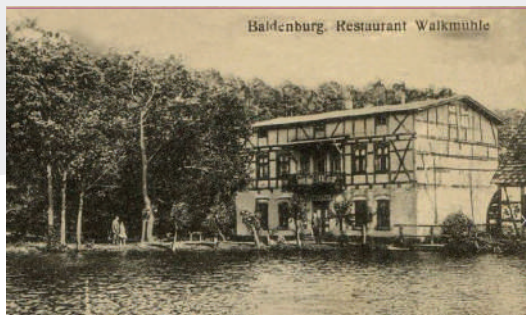
Ryglowy budynek restauracji Walkmühle; okres międzywojenny
