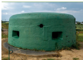
Kopuła sześciostrefnicowa zachowana na Międzyrzeckim Rejonie Umocnionym; fot. Maciek Leszczetowski
