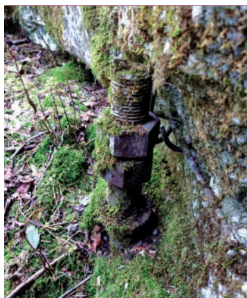
Kotwa do mocowania kopuły pancernej 27P w schronie bojowym Karz.8;
