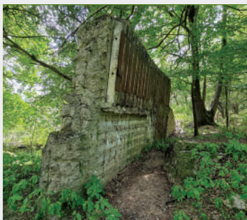
Strop zburzonego dwusektorowego schronu Du.10; fot. Jarosław Leszczeńowski
