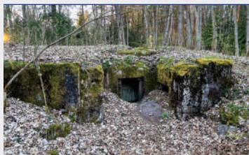
Schron E.1, stanowisko ogniowe ckm ostonięte niegdyś kazamatą pancerną; fot. Jarosław Leszczetowski
