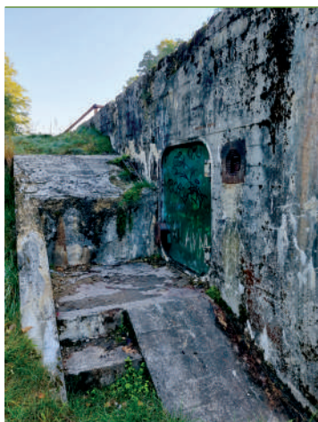
Wejście do bloku eksploatacyjnego; fot. Jarosław Leszczeński
