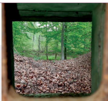
Widok na zapole schronu Karz.30 przez strzelnicę obrony zewnętrznej; fot. Jarosław Leszczelewski
