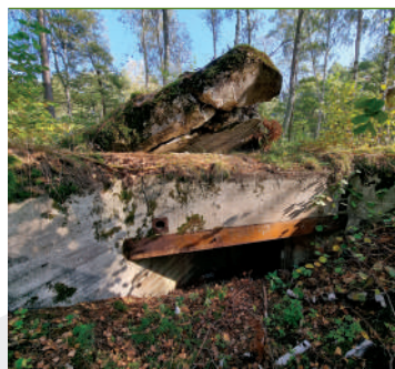
Elewacja wejściowa schronu Pil.8 z charakterystycznym okapem; fot. Jarosław Leszczetowski
