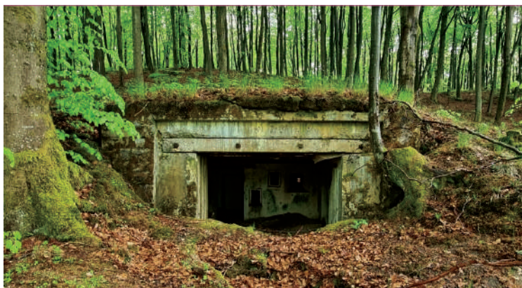
Malowniczo położony schron Karz.20; widoczne są cztery kotwy do mocowania płyty pancernej ostaniającej izbę bojową; fot. Jarosław Leszczetowski
