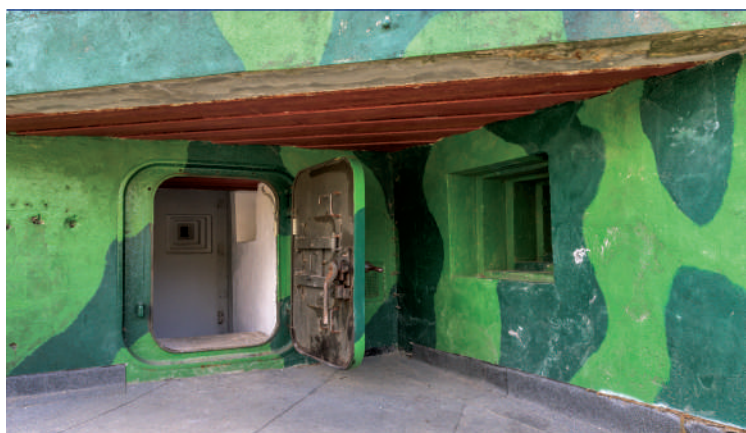
Wejście do schronu N.2 ze zrekonstruowanymi stalowymi drzwiami; wejście chronione było przez zewnętrzną strzelnicę (po prawej ambradura strzelnicy) oraz strzelnicę obrony wewnętrznej; fot. Maciek Leszczetowski
