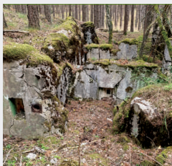
Schron G.B.9; widok od elewacji wejściowej, widać podział na poszczególne pomieszczenia, przedsionek oraz izby pogotowia i bojową; w przedsionku widoczna ambrazura strzelnicy; fot. Jarostaw Leszczetowski
