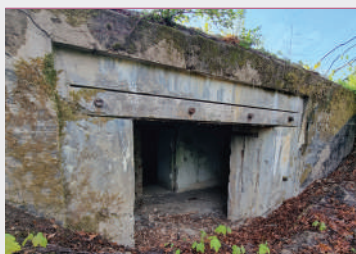
Schron Karz.26; widok od czola; widoczne są kotwy do mocowania płyty pancernej ze strzelnicą; fot. Jarosław Leszczetowski
