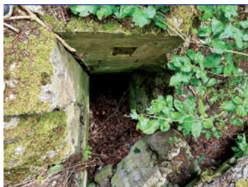
Schron N.35, stanowisko obserwatora; fot. Jarostaw Leszczetowski
