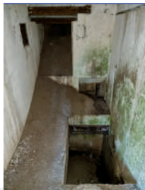
Pomieszczenie z szybem i wyjściem awaryjnym w schronie E.15; fot. Jarosław Leszczeński
