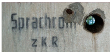
Rura głosowa łącząca izby pogotowia i bojową w schronie De.51; fot. Jarosław Leszczetowski
