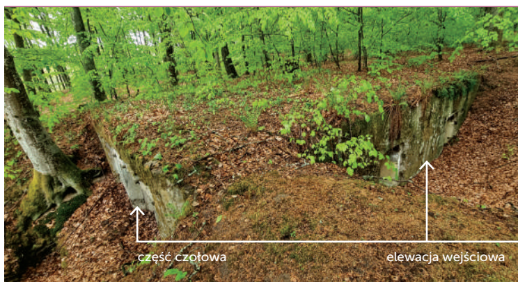
schron Karz.16; płaszczyzny części czołowej i wejściowej położone są pod kątem 90 stopni; fot. Jarosław Leszczetowski
