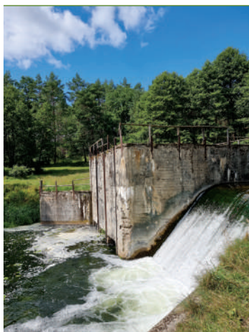
Widok od strony zachodniej; fot. Jarosław Leszczeński
