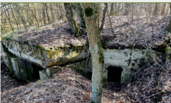
Dwusektorowy schron Lz.2; wejście i jedno z dwóch stanowisk ogniowych; fot. Jarosław Leszczeńowski
