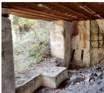
Izba bojowa Pił.2 z dobrze zachowaną podstawą na stółforteczny, na którym montowano ckm MG08; fot. Jarostaw Leszczetowski
