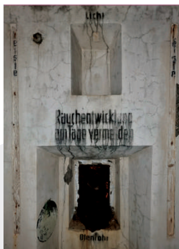
Schron Karz.26; nisza na lampkę naftową (opis: Licht ), poniżej napis przypominający o konieczności unikania dymienia w dzień, co demaskowałoby potożenie schronu, na dole rura piecowa (opis: Ofenrohr ), po lewej namalowany czarny okrąg oznacza miejsce do zawieszenia fajerek pieca; po obu stronach listwy drewniane (opis: Leiste ); fot. Jarosław Leszczetowski
