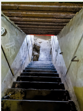
Zejście do części podziemnej Grupy Warownej „Śmiadowska Góra”; fot. Jarosław Leszczetowski
