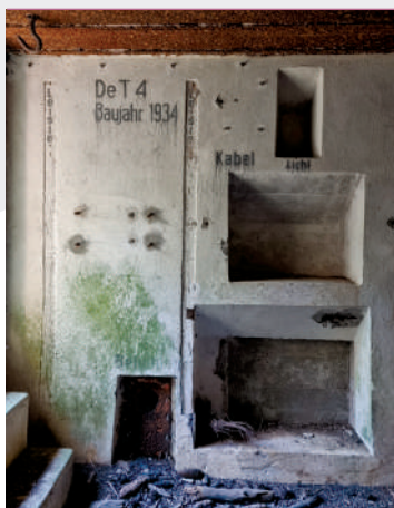
Wnętrze izby żołnierskiej schronu De.T4 ; od lewej schodnia wejściowa, sygnatura między listwami, rura odpowietrzania, nisze dla oświetlenia i skrzynki kablowej instalacji telefonicznej; fot. Jarosław Leszczetowski
