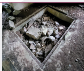
W wielu schronach odcinka De. w podłogach znajdowały się nisze, które przykrywano deskami; fot. Jarosław Leszczetowski
