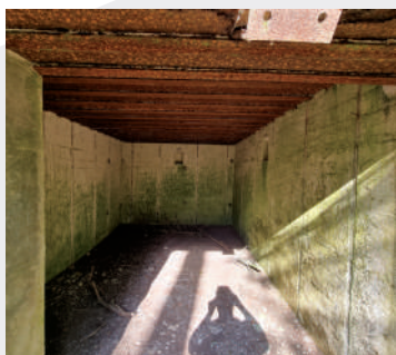
Schron De.T3 pomieszczenie garażowe; fot. Jarosław Leszczetowski
