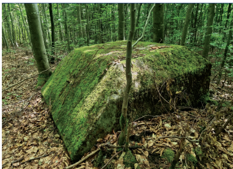
Jedna z czterech podstaw odciągów wieży obserwacyjnej F.N.B.3 w zachodniej części Lasu Szczecineckiego; fot. Jarostaw Leszczetowski
