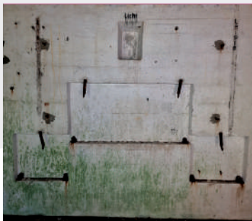
Nisze na składane siedzenia i stół w schronie Br.10; fot. Jarosław Leszczeńowski
