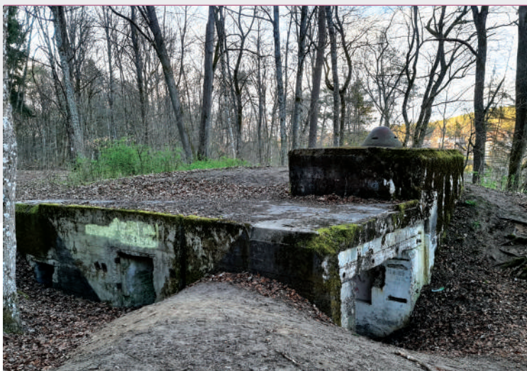
Schron B.20; widoczne są od lewej: wyjście awaryjne, wejście do schronu, izba bojowa i nad nią stanowisko obserwatora z kopułą pancerną 9P7; fot. Jarosław Leszczeński
