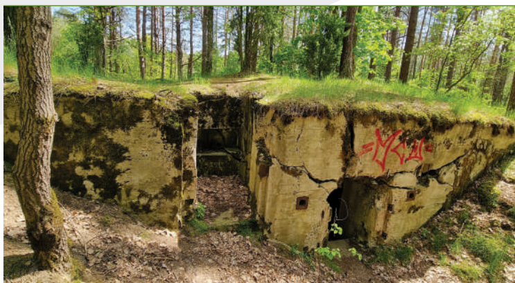
Schron Br.8; po lewej stanowisko obserwatora; po prawej wejście do schronu; fot. Jarostaw Leszczetowski
