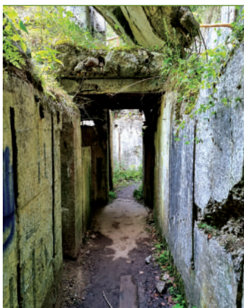
Korytarz w dolnej kondygnacji schronu Pz.W.975 ; fot. Jarosław Leszczeńowski
