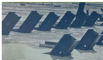
Zapora przeciwczołgowa ze stalowymi dwuteownikami umieszczonymi w otworach; zdjęcie archiwalne
