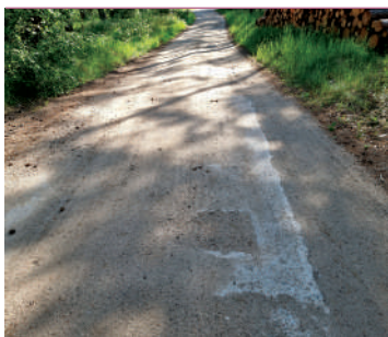
Fragment betonowej zapory przeciwczołgowej na drodze do Radzewa;
