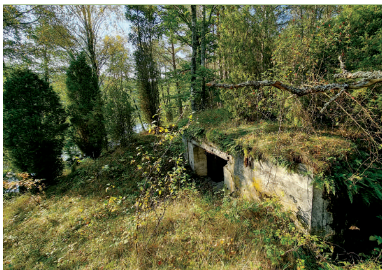
Schron. Pil.2; po lewej za jałowcami pobytyskują wody rozlewiska Piławy; fot. Jarosław Leszczelewski
