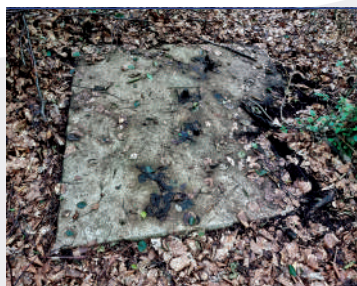
Jedna z czterech podstaw wieży obserwacyjnej F.N.B.3; fot. Jarostaw Leszczetowski;
