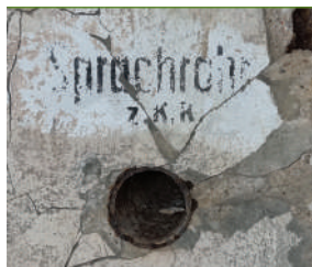
Rura głosowa; schron Zm.8; fot. Jarosław Leszczetowski
