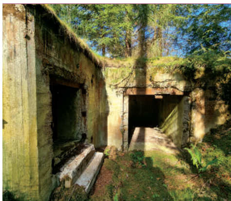
Elewacja wejściowa schronu biernego De.T3 przeznaczonego dla działka przeciwpancernego i jego obsługi; fot. Jarosław Leszczetowski
