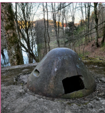
Po lewej stanowisko obserwatora w schronie B.20; po prawej obserwacyjna kopuła pancerna 9P7 w schronie B.20, na drugim planie kanał; fot. Jarosław Leszczeńowski
