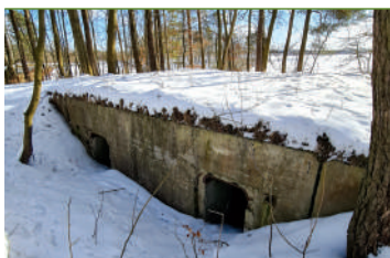
Elewacja wejściowa schronu Du.30; fot. Jarosław Leszczetowski
