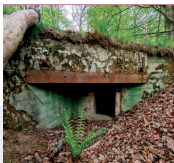
Pomalowana na maskujący kolor elewacja wejściowa schronu Karz.14A z charakterystycznym okapem; fot. Jarosław Leszczelewski
