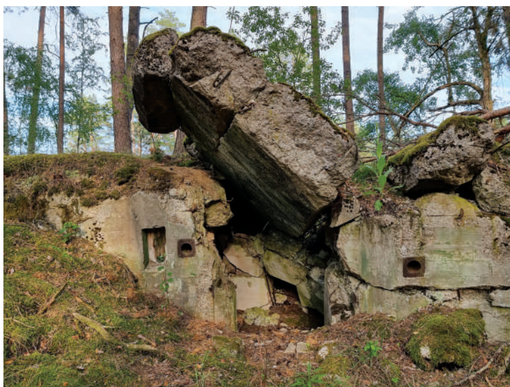
Elewacja wejściowa schronu G.B.10; fot. Jarosław Leszczeński
