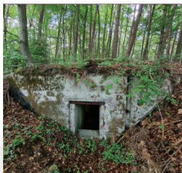
Elewacja wejściowa schronu B.27 z jednym wejściem i niszą na komin instalacji grzewczej; fot. Jarosław Leszczetowski
