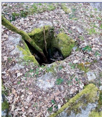
Schron E.1; stanowisko obserwatora – widok z góry; fot. Jarosław Leszczyński
