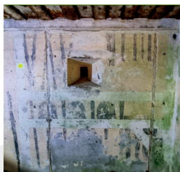
Strzelnica obrony wewnętrznej i kontury łopatek saperskich oraz toporków oznaczające miejsce ich przechowywania; przedsionek schronu Du.30; fot. Jarostaw Leszczetowski
