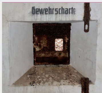
Strzelnica obrony wewnętrznej; schrony Karz.18 i Karz.17; fot. Jarosław Leszczetowski
