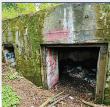
Elewacja wejściowa schronu biernego N.T.1; fot. Jarostaw Leszczetowski
