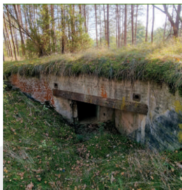
Elewacja wejściowa schronu Pił.1; fot. Jarostaw Leszczetowski
