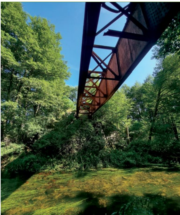
Pozostałości mostu kolejowego (linia Jastrowie – Czaplinek) nad Piławą w okolicach Nadarżyc; fot. Jarosław Leszczetowski
