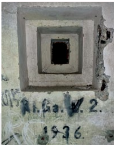
Ambrazura strzelnicy, sygnatura i rok budowy; fot. Jarostaw Leszczetowski
