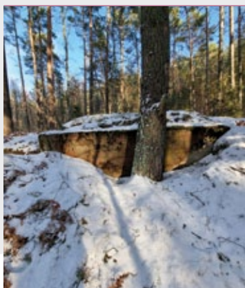
Schron pozorny na odcinku taktycznym Kle.; fot. Jarosław Leszczetowski
