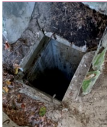
Szyb w bloku obserwacyjnym z kopułą 44P8; fot. Jarosław Leszczetowski
