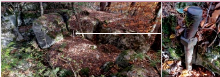
Schron KL.Ga.2; podstawa koputy pancernej 3P7 i gwintowany trzpień mocujący; fot. Jarosław Leszczetowski
