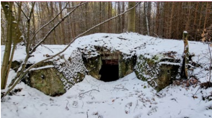
Schron Kl.Ga.S5, strona czołowa, na pierwszym planie zniszczone stanowisko ogniowe ckm, które osłaniała niegdyś kazamata; widać też otwór drzwiowy prowadzący do niewielkiej izby żołnierskiej; fot. Jarosław Leszczetowski
