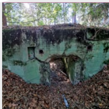
Elewacja wejściowa z malowaniem maskującym; schron Strau.W.7 fot. Jarosław Leszczeński
