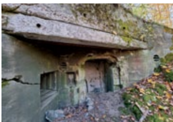
Elewacja wejściowa schronu KL.Ga.3; od lewej strzelnica, wyprowadzenie linii telefonicznej i drzwi wejściowe; widać też okrągłe otwory wentylacyjne z ostonami; fot. Jarosław Leszczetowski
