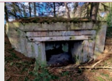
Elewacja wejściowa schronu Ru.17/18; po lewej ambrazura strzelnicy obrony zewnętrznej; widoczne są dwa wejścia, otwory wentylacyjne i nisza do podłączenia polowej linii telefonicznej; fot. Jarosław Leszczetowski
