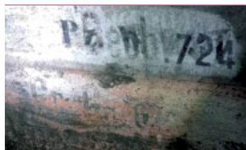
Napis na ścianie wskazujący drogę do bloku obserwacji artyleryjskiej; widoczne są trzy różne sygnatury tego bloku: Pz.W.724, Beob. i Gr.Ga.6
