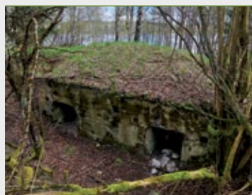
Elewacja wejściowa schronu Da.9; fot. Jarostaw Leszczetowski
