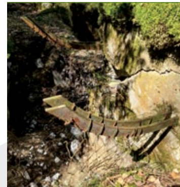
Doskonale zachowane wsporniki z fragmentami metalowej siatki; fot. Jarosław Leszczetowski
