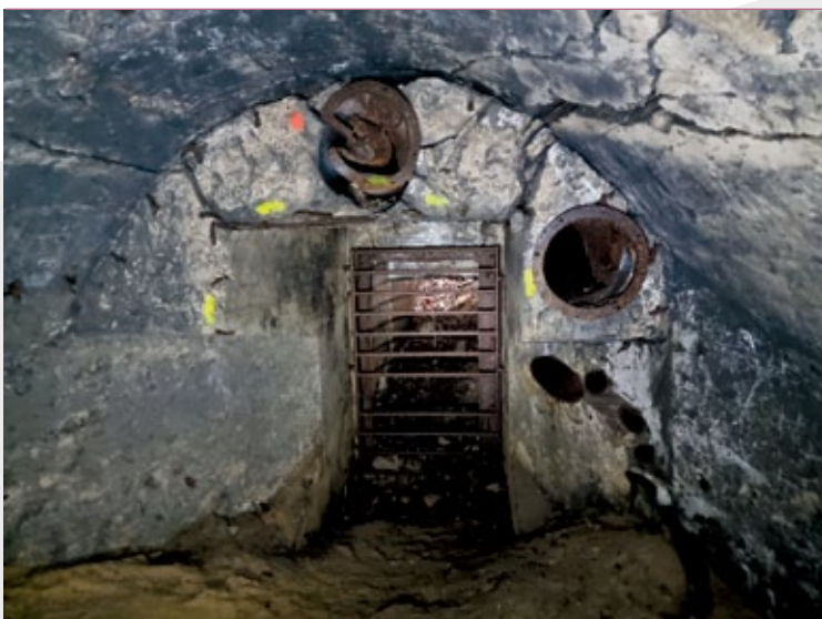
Zabezpieczone kratą wejście do szybu bloku wejściowego B; fot. Jarosław Leszczetowski
