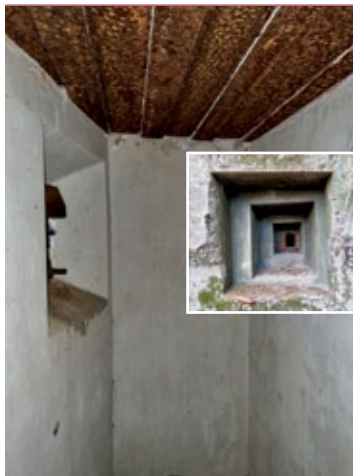
Ambradura zewnętrznej strzelnicy i wnęka wartownika; schron Ru.17/18; fot. Jarostaw Leszczetowski
