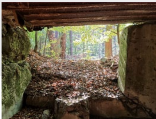
Schron Strau.W.16, dobrze widoczne mocowanie płyty pancerniej ze strzelnicą; fot. Jarosław Leszczeński
