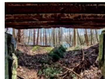
Stanowisko ckm chronione było niegdyś płytą pancerną, w której umiejscowiony był otwór strzelniczy zabezpieczony stalową zasuwą; na drugim planie Jezioro Dobre; fot. Jarosław Leszczeński
