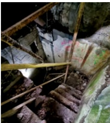
Szyb – klatka schodowa w bloku wejściowym A; fot. Jarosław Leszczetowski
