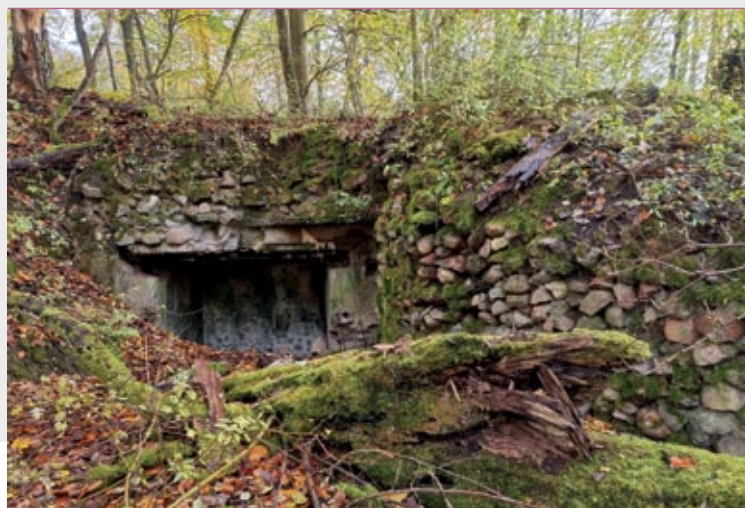
Schron Gr.Ga.1 z kamiennym maskowaniem elewacji; fot. Jarosław Leszczelewski
