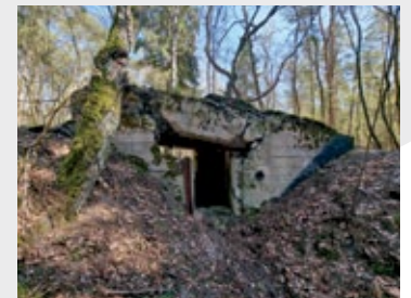
Elewacja wejściowa schronu PI.2; fot. Jarosław Leszczeński
