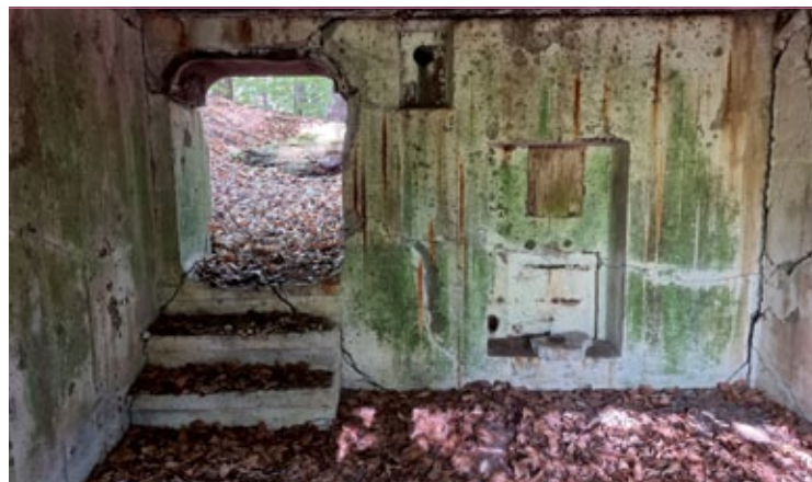
Schron Strau.W.15; po prawej wejście ze schodnią, w środku otwór wentylacyjny, po prawej wnęka skrzynki kablowej (niem. Verteiler); fot. Jarosław Leszczeński
