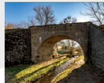
Most nad Młynówką na dawnej linii kolejowej Jastrowie-Złotów; fot. Maciek Leszczełowski
