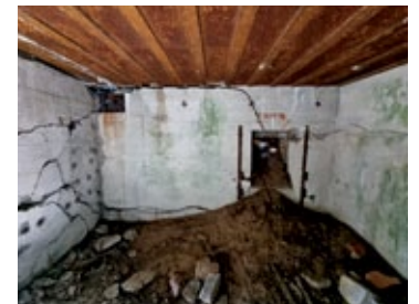
Schronu PI.Bef.5; izba pogotowia z wyjściem awaryjnym, rurą piecową i zaczepami instalacji telefonicznej; fot. Jarosław Leszczeński
