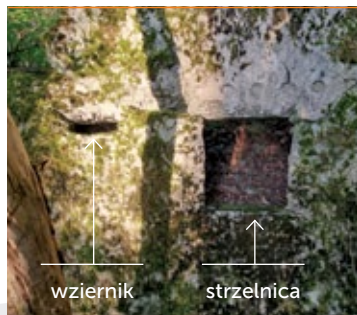
Czołowa ściana z wziernikiem obserwacyjnym i strzelnicą w schronie Grü.S.3; fot. Jarosław Leszczetowski
