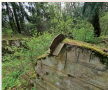
Fragment elewacji wejściowej schronu S.T.K.2; fot. Jarosław Leszczetowski
