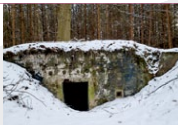
Elewacja wejściowa schronu Kl.Ga.S5; fot. Jarosław Leszczetowski
