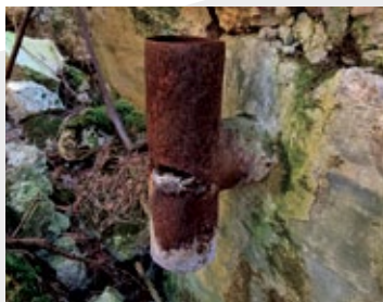
Fragment rury kominowej; schron Zie.7/8; fot. Jarosław Leszczelewski
