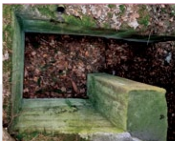
Stanowisko obserwatora w schronie PL.8, widok z góry; fot. Jarostaw Leszczetowski
