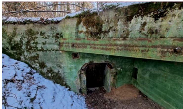
Elewacja wejściowa schronu Kle.6 z malowaniem maskującym; widoczne są wejście, otwór wentylacyjny i nisza wyprowadzenia linii telefonicznej; fot. Jarosław Leszczetowski
