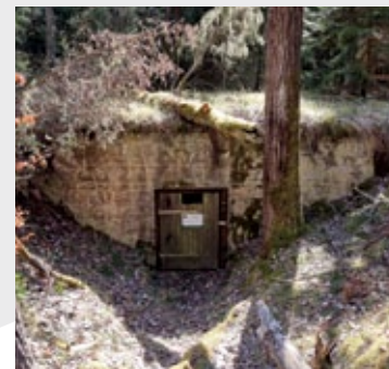
Elewacja wejściowa schronu Grü.N.8; fot. Jarosław Leszczański
