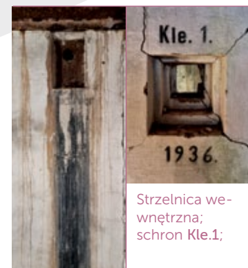
Rura piecowa i oznaczone czarnym pasem miejsce do montowania piecyka schronu Kle.1; fot. Jarosław Leszczeński
