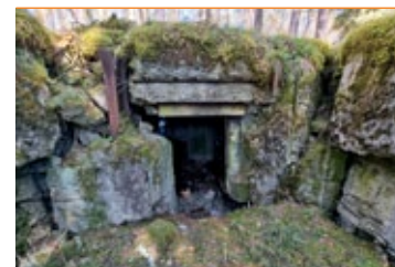
Schron Grü.N.10, zrujnowana izba bojowa i otwór drzwiowy prowadzący do pomieszczenia gotowości; fot. Jarosław Leszczański
