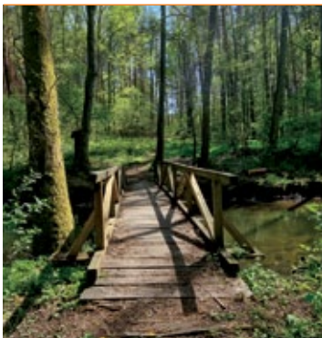
Mostek na Cieszynce niedaleko Góry Zamkowej; fot. Jarosław Leszczetowski
