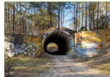
Elewacja wejściowa schronu GRANIT; fot. Jarosław Leszczetowski
