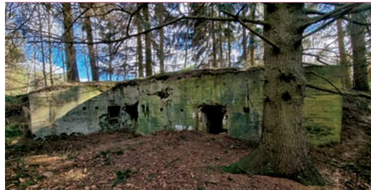
Elewacja wejściowa schronu Ru.17/18; po lewej ambrazura strzelnicy obrony zewnętrznej; widoczne są dwa wejścia, otwory wentylacyjne i nisza do podłączenia polowej linii telefonicznej; fot. Jarosław Leszczetowski
