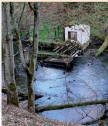
Pozostałości elektrowni z kotłem wodnym; fot. Jarosław Leszczetowski
