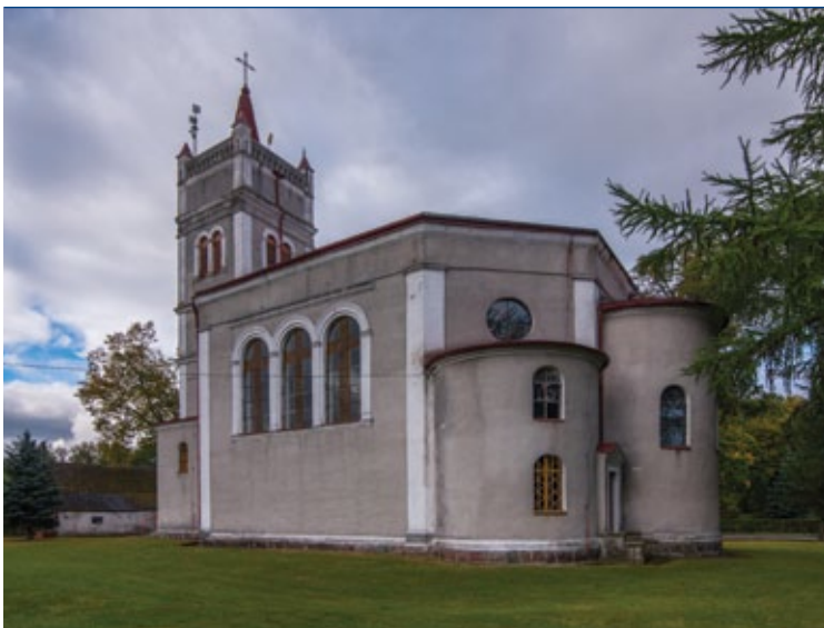
Neoromański kościół w Lubnie wybudowany w 1876 r.; fot. Maciek Leszczetowski
