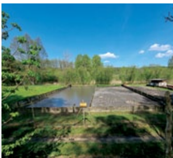
Oczyszczalnia ścieków w Człtopie; fot. Jarosław Leszczetowski
