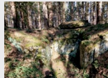
Schron Ru.22; widok od czoty; strop widocznej izby bojowej został odrzucony na dach bunkra w wyniku wybuchu; fot. Jarostaw Leszczetowski
