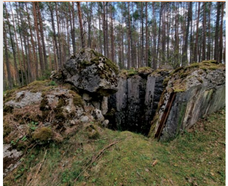
Schron na studnię; fot. Jarosław Leszczeński
