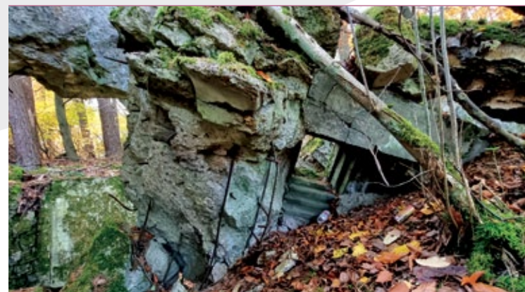
Fragment zrujnowanej zewnętrznej strzelnicy ostony wejścia schronu Kl.Ga.6; fot. Jarosław Leszczetowski
