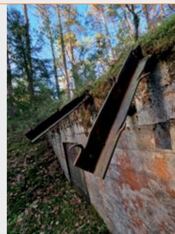
Schron S.T.F.1; wsporniki na siatkę maskującą; fot. Jarosław Leszczeński
