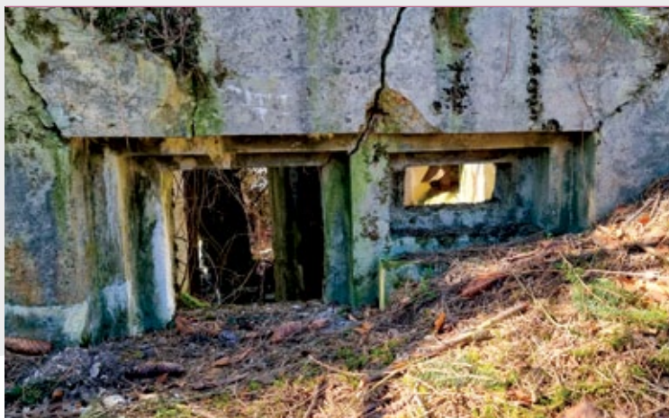
Ambrazury strzelnicy ckm i wziernika do obserwacji; schron Zie.7/8; fot. Jarosław Leszczelewski
