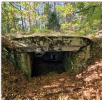
Schron Strau.W.16, dobrze widoczne mocowanie płyty pancerniej ze strzelnicą; fot. Jarosław Leszczeński
