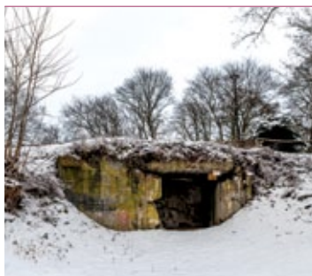
Schron bojowy T.5; fot. Maciek Leszczetowski
