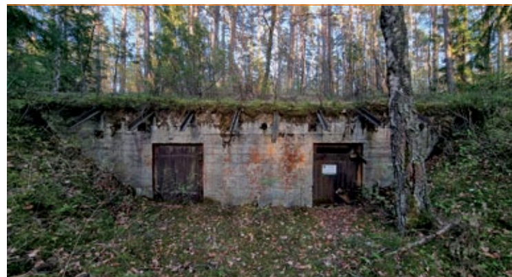
Elewacja wejściowa schronu dowodzenia S.T.F.1; fot. Jarosław Leszczeński
