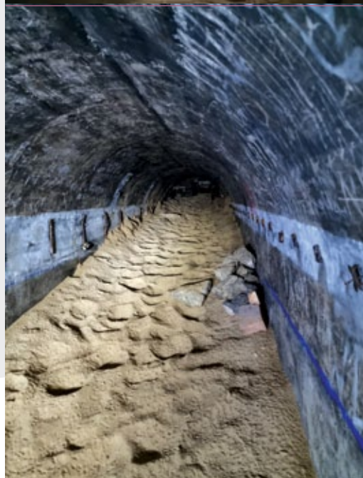
Zasypany końcowy fragment chodnika prowadzącego do bloku obserwacji artyleryjskiej z kopułą 21P7; fot. Jarosław Leszczełowski
